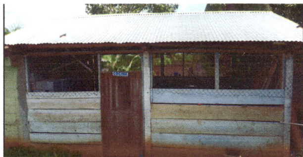
Foto 5: LAS PARERES DE LA COCINA EN EL TIEMPO DE INVIERNO PERMITE QUE ENTRA AGUA, LOS ESTUDIANTES SE MOJAN POR EL ESTADO EN QUE SE ENCUENRTRA.
